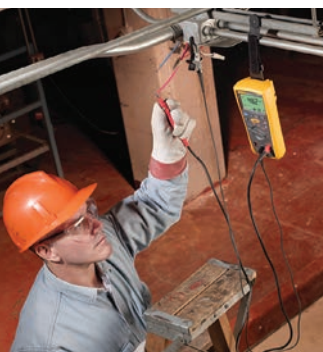
Магнитное подвесное устройство освобождает руки для безопасного проведения измерений
