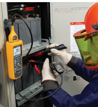
Измерение импеданса с помощью прибора для проверки АКБ Fluke BT521
